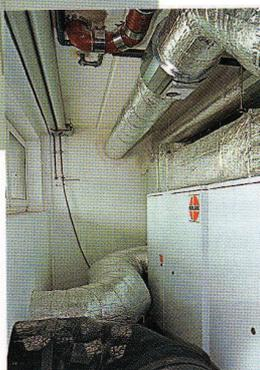
Rechts: Brandschutzklappen in den Deckendurchgängen verhindern die Rauchausbreitung in den Lüftungsleitungen
